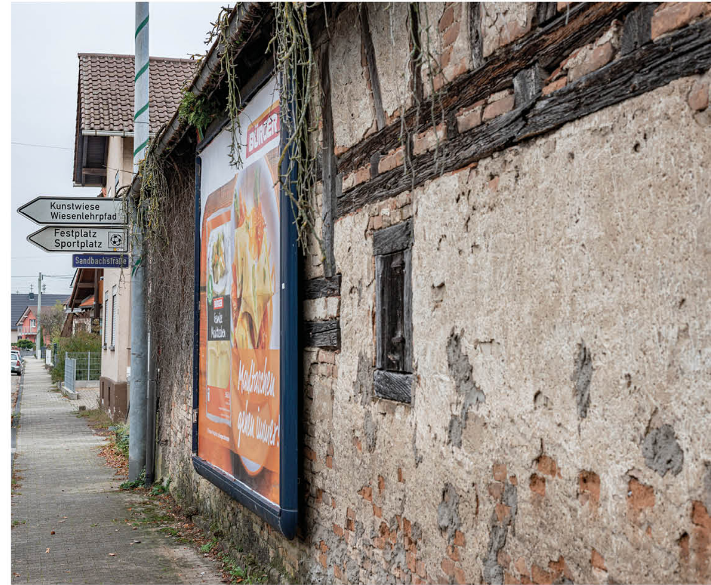
Fachwerkscheune mit Modernisierungsbedarf
