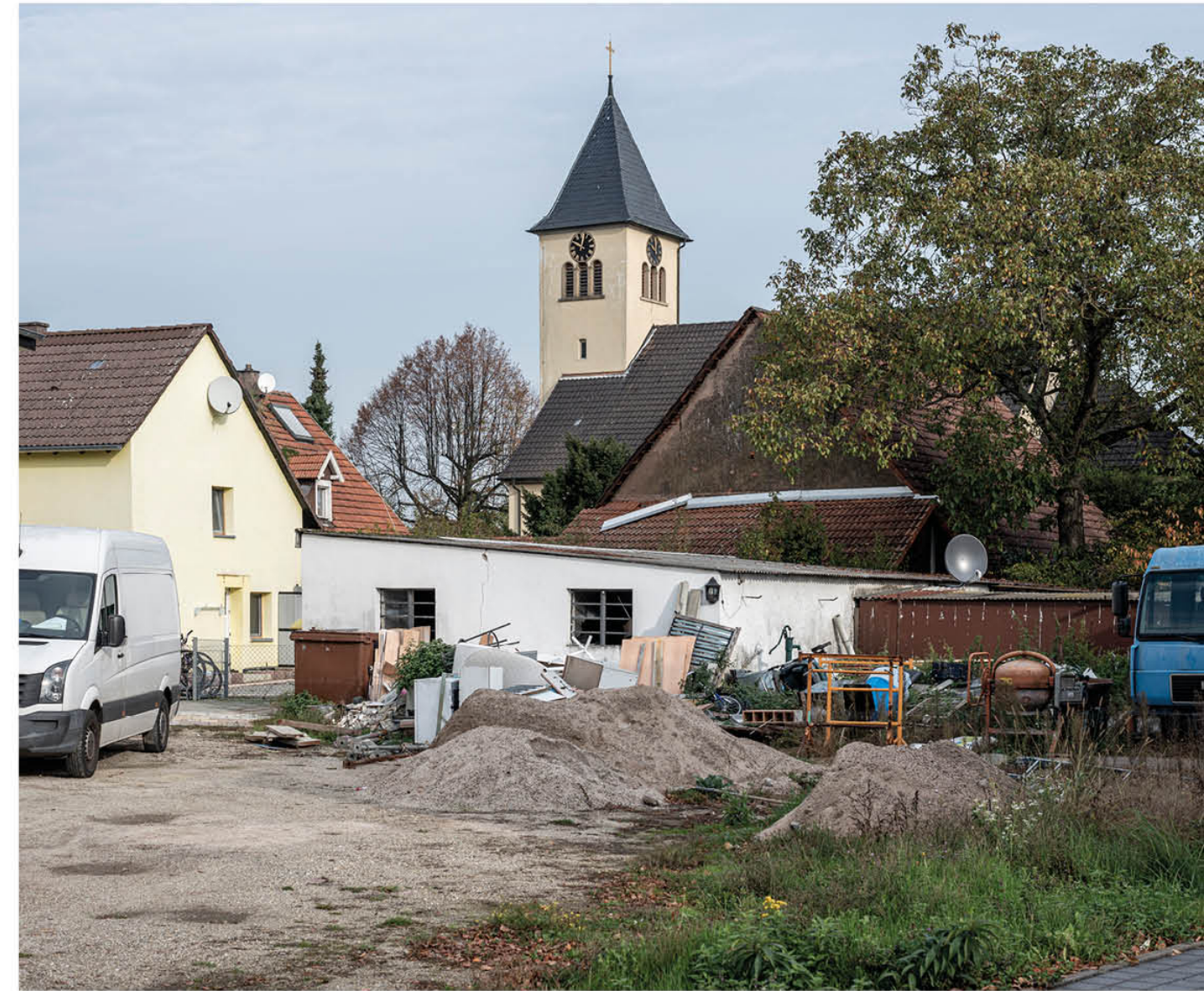
Ehemaliges Gasthaus Linde im Umbau
