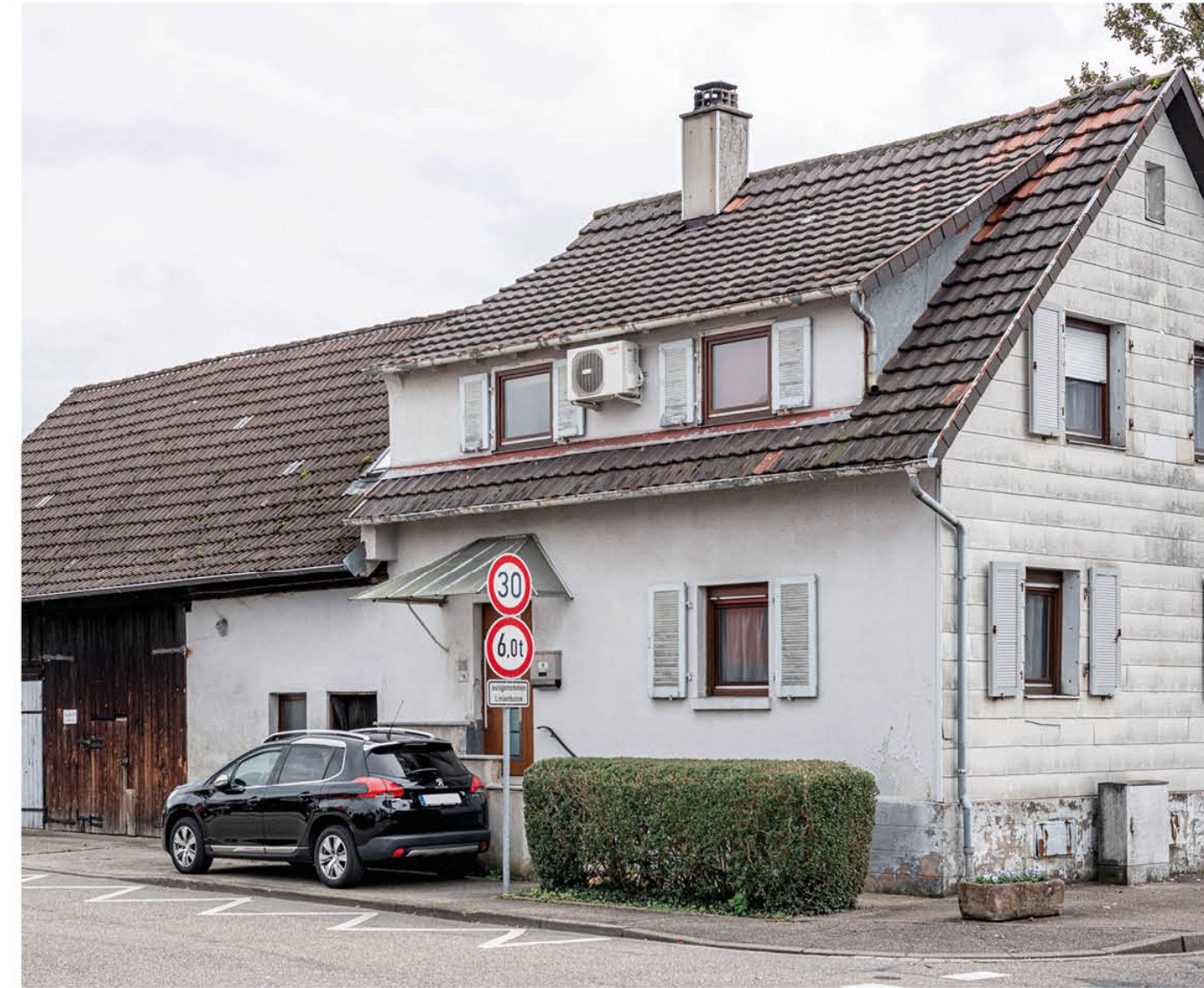
Gebäude an der Ortsdurchfahrt vermitteln sanierungsbedürftigen Eindruck
