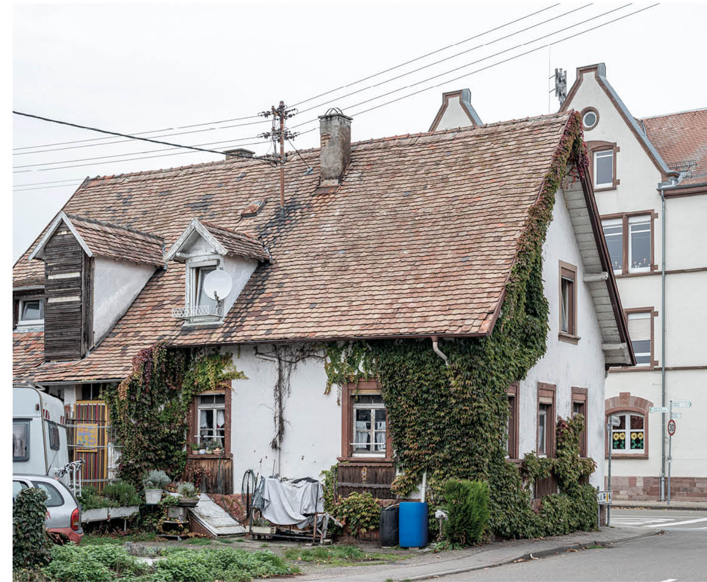
Modernisierungsbedürftiges Gebäude an der Ortsdurchfahrt Fährstraße
