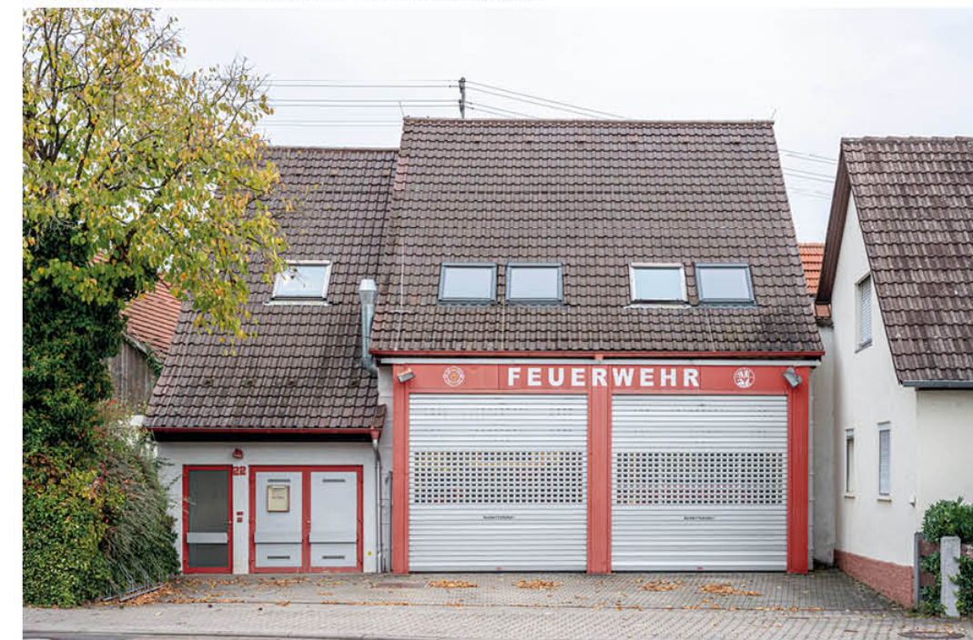
Die alte Feuerwache wird nach dem Neubau leer stehen
