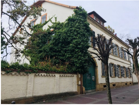
Abbildung 8: ehem. Verwaltungsgebäude (denkmalgeschützt), Project GmbH, 25.10.2018
