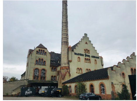
Abbildung 9: Brauereigebäude, Project GmbH, 25.10.2018
